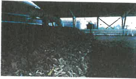
Photo des écorces broyées et de la fibre de coco en cours de remplissage sur le caillebotis du biofiltre.
